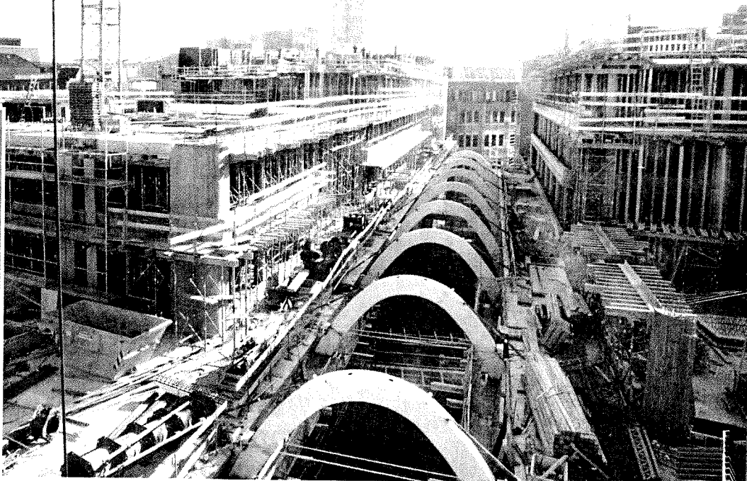
20 Meter hohe Bögen sind quer durch die 160 Meter lange Passage verteilt
